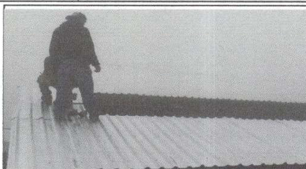
Foto 2: CAMBIO DE LAMINA TROQUELADA
