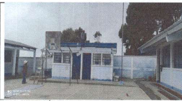
Foto 5: SUSTITUCIÓN DE LAMINA TROQUELADA
