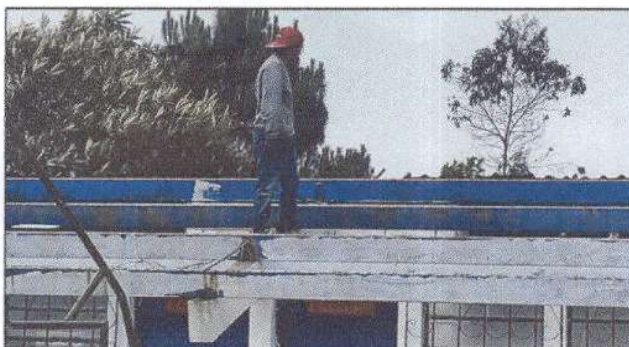
Foto 3: CAMBIO DE LAMINA TROQUELADA
