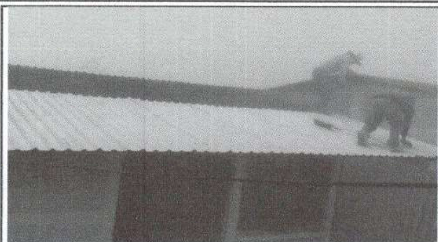
Foto 1: CAMBIO DE LAMINA TROQUELADA
